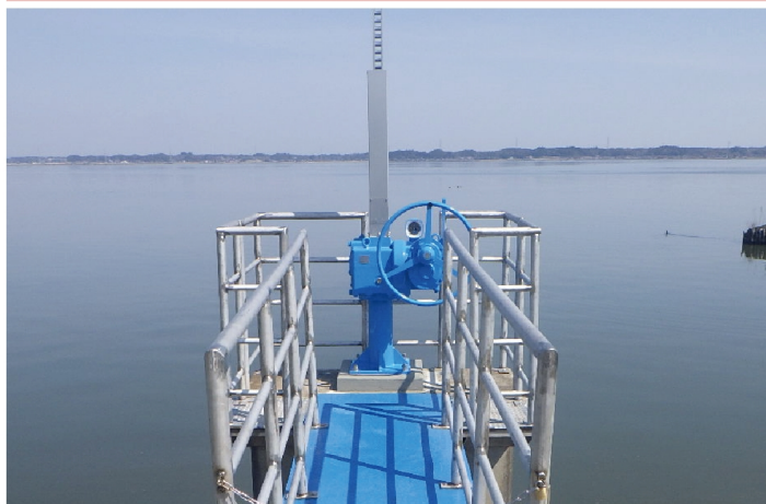
令和2年度 農業生産基盤整備事業 安飾地区 樋門ゲート及び開閉機の改修工事 (2020)
